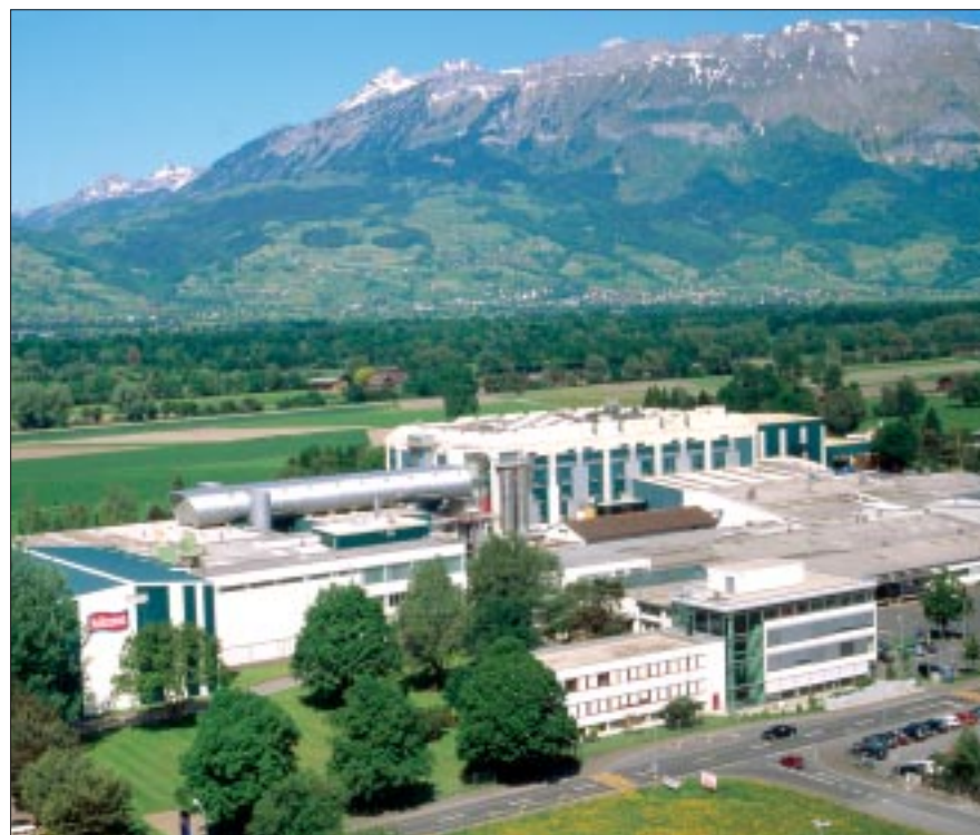
Hauptsitz. Heute ist die Hilcona-Gruppe einer der grössten Arbeitgeber im «Ländle». Im Bild der organisch gewachsene Hauptsitz in Schaan. Die Röhre in der Bildmitte ist die Schleuse zwischen der Aussenwelt und dem Reinbereich der Produktion.
