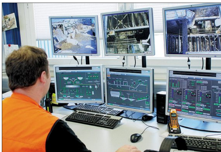
Automatisierte Verarbeitung: Im zentralen Leitstand werden die einzelnen Verarbeitungsschritte gesteuert und überwacht.
